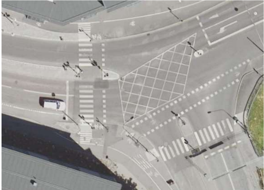
Bild 7. Flygfoto över korsningen med Karlsbodavägen från 2022 efter ombyggnation. Cykelbanan från Bällstavägen ansluter mot bronns norra cykelbana, cykelöverfarten över Karlsbodavägen leder cyklister till bronns södra cykelbana. Cykelöverfarten över Bällstavägen ligger öster om övergångsstället.
