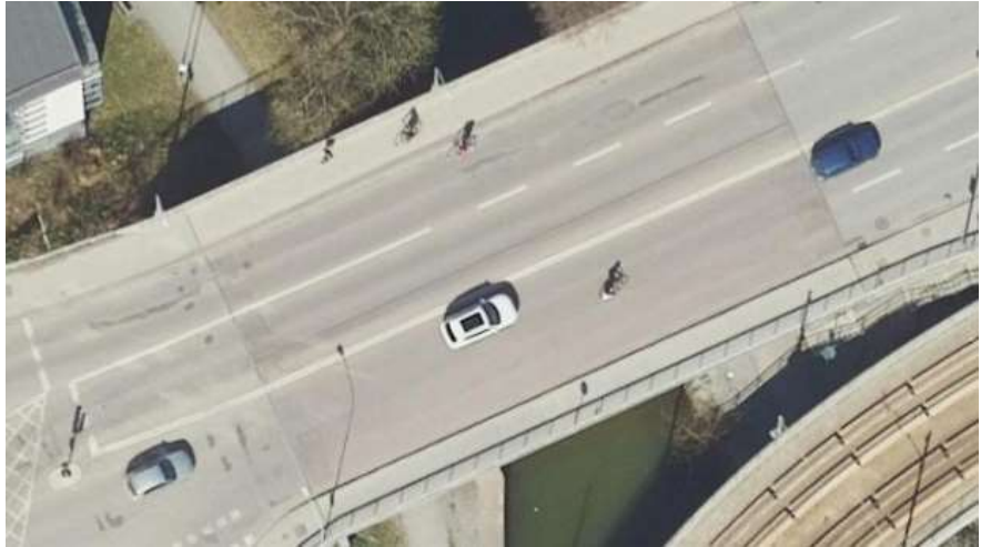
Bild 2. Flygfoto över Bällstabro från 2021 före ombyggnation. Bron har fyra överbredda körfält och gångbana på vardera sidan.
