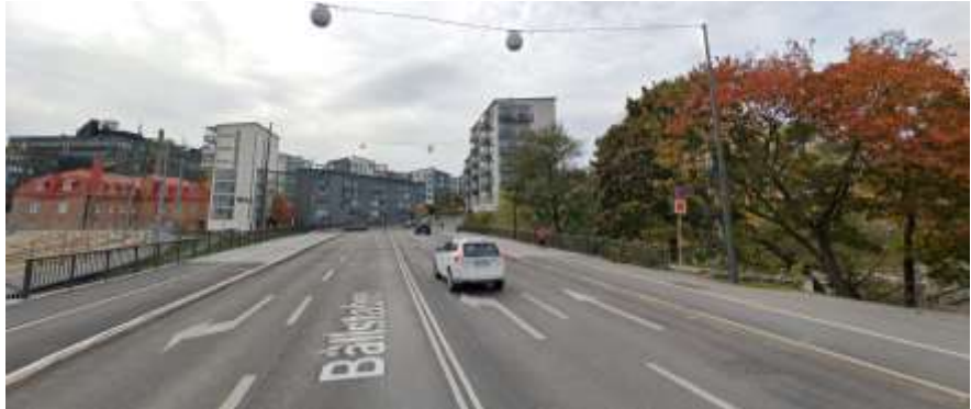
Bild 5. Gatuvy västerut över Bällstabro efter ombyggnation. Brons fyra körfält och gångbanor har smalnats av och gett plats åt enkelriktade cykelbanor. Bron har fått ny linspänd belysning.
