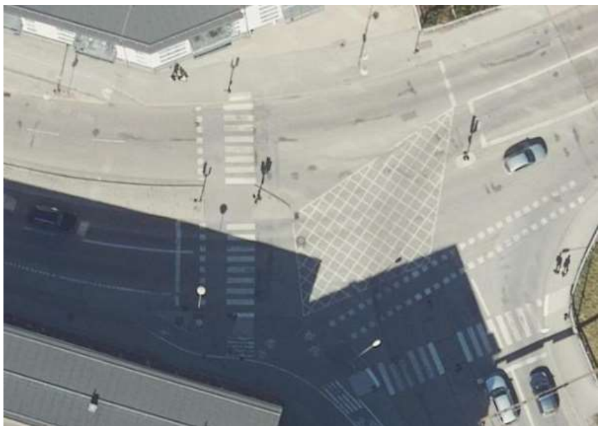
Bild 6. Flygfoto över korsningen med Karlsbodavägen från 2021 före ombyggnation. Cykelbanan från Bällstavägen leds ut i körbanan och cykelöverfarten över Karlsbodavägen leder cyklister ut i körbanan på Bällstabro. Cykelöverfarten över Bällstavägen ligger väster om övergångsstället.
