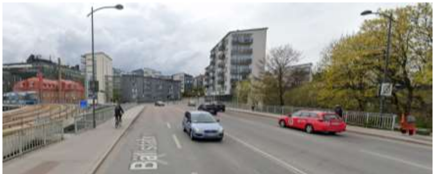
Bild 4. Gatuvy västerut över Bällstabro före ombyggnation. Bilden visar fyra breda körfält samt gångbanor på respektive sida. Cykelbanor saknas.
