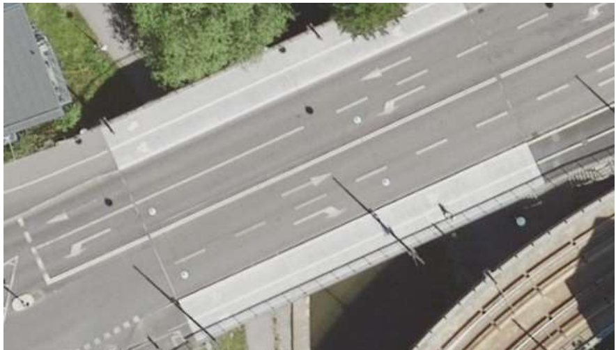
Bild 3. Flygfoto över Bällstabro från 2022 efter ombyggnation. Brons fyra körfält och gångbanor på respektive sida har smalnats av och gett plats åt enkelriktade cykelbanor.
