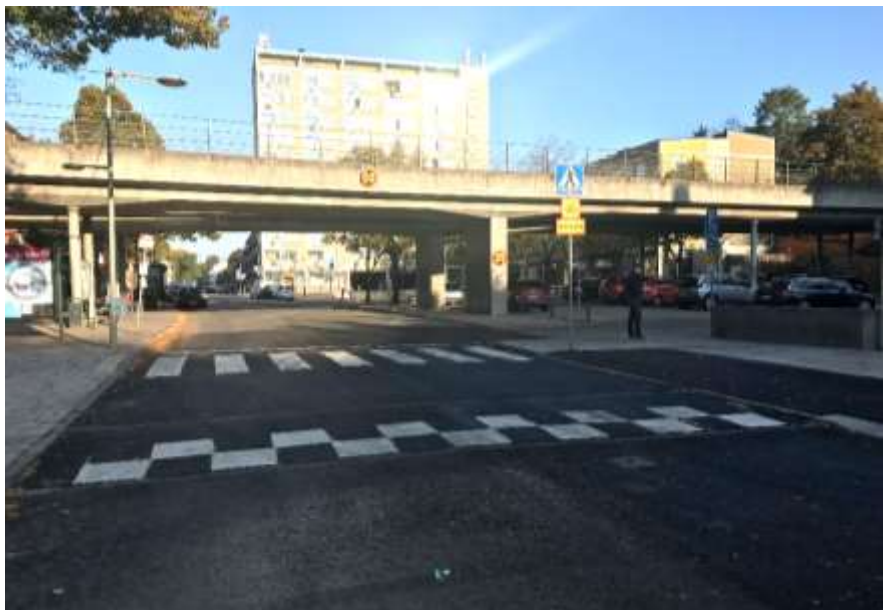
Bild 2. Fotografi som visar ett tillgänglighetsanpassat och hastighetssäkrat övergångsställe på norra delen av Störtloppsvägen efter ombyggnationen.
