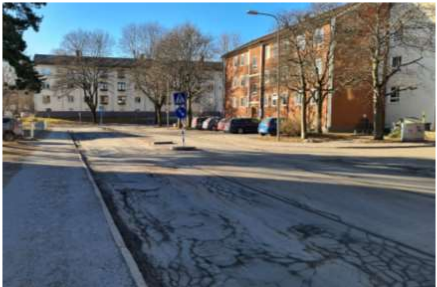
Bild 8. Fotografi på övergångsställe på Störtloppsvägen i höjd med Isgränd före ombyggnationen.
