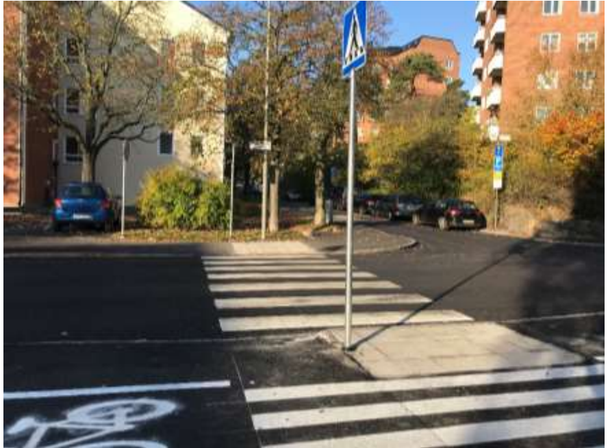
Bild 9. Fotografi på tillgänglighetsanpassat övergångsställe på Störtloppsvägen i höjd med Isgränd efter ombyggnationen.
