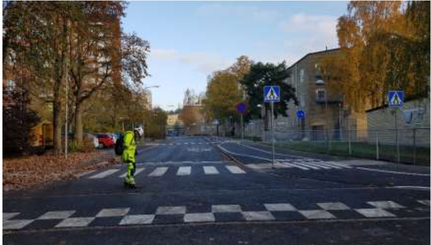
Bild 11. Fotografi på tillgänglighetsanpassat och hastighetssäkrat övergångsställe på södra delen av Störtloppsvägen efter ombyggnationen.
