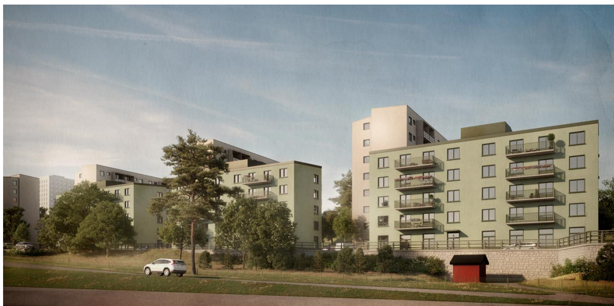
Vy över ny bebyggelse inom kvarteret Stubbneken från Huddingevägen. Bilder: Tengbom.
