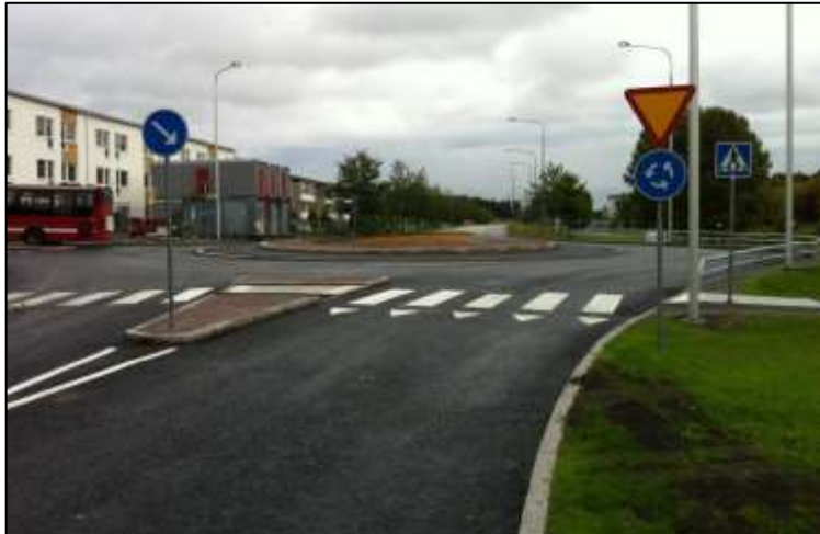
Bild 6: Cirkulationsplats med ej överkörningsbar rondell
