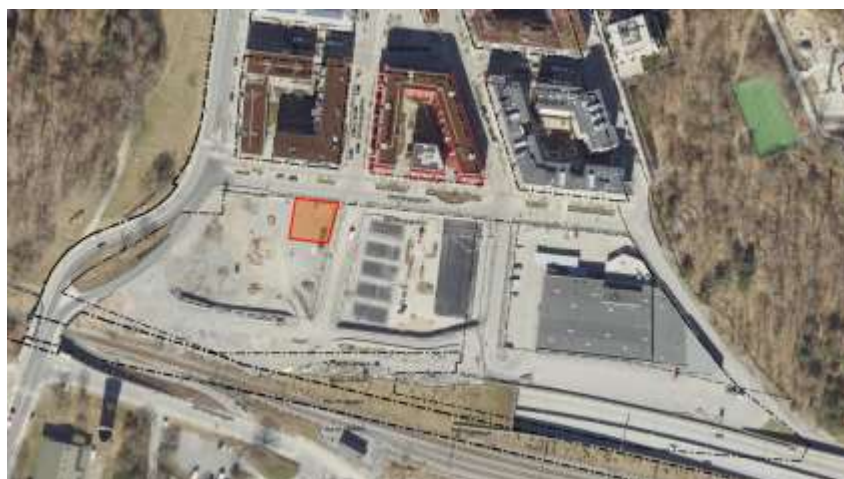
Del av Ångsbotten 6 där befintlig pumpstation är byggd och som eventuellt kan komma att markanvisas i senare skede.
