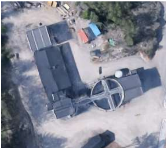
Flygfoto över Sofielunds Reningsverk som ska byggas ut.
