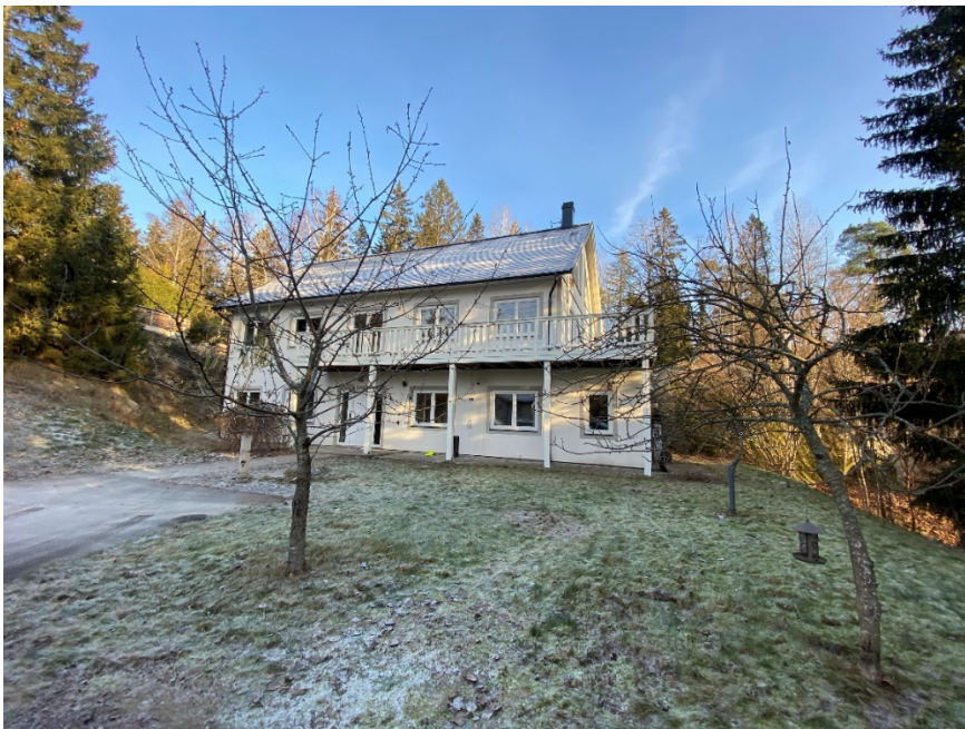
Figur 5. Fotografi visar befintlig huvudbyggnad.
