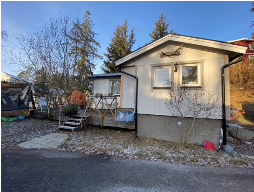
Figur 6. Fotografi av befintlig komplementbyggnad.
