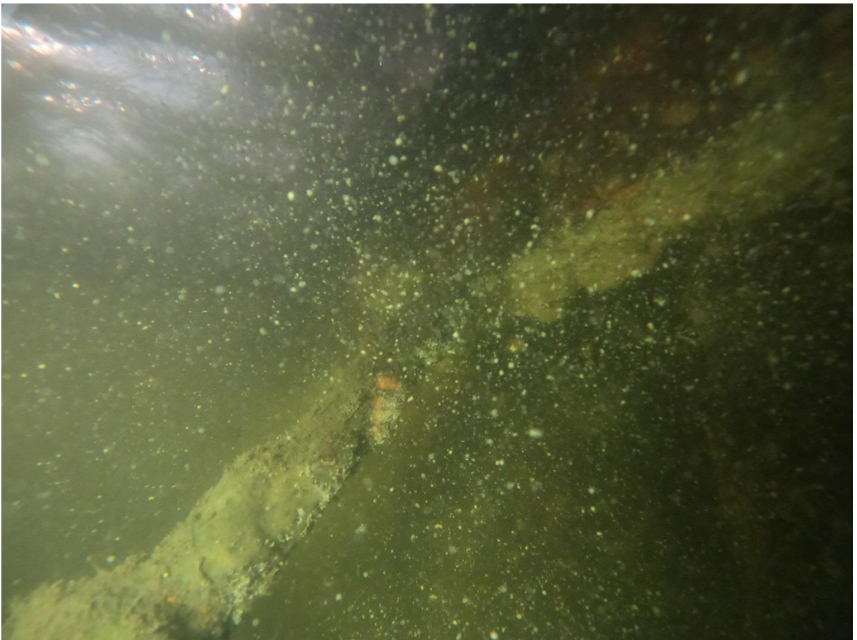
Bild 9: Avrostat förankringsstag.
