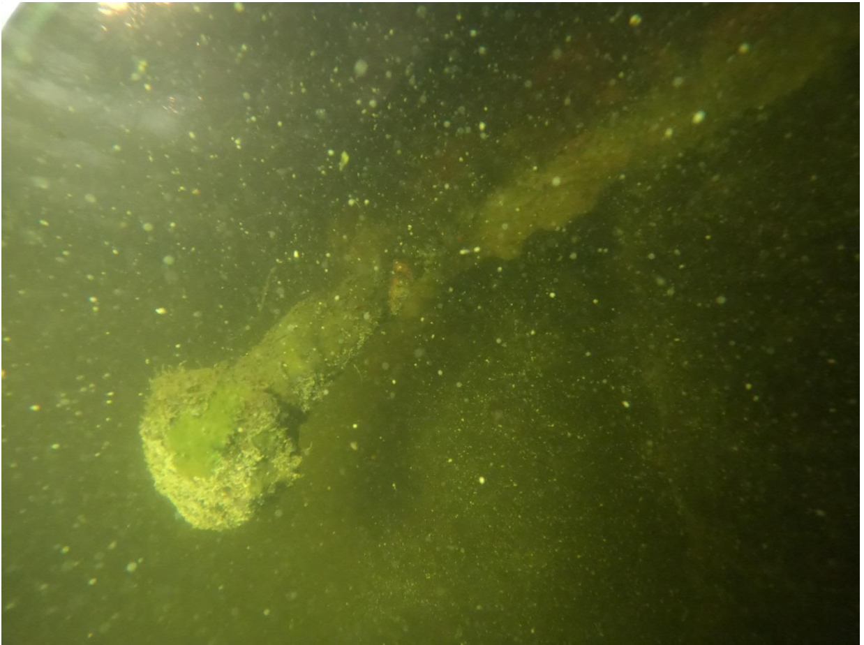
Bild 8: Avrostad förankringsstagsinfästning.
