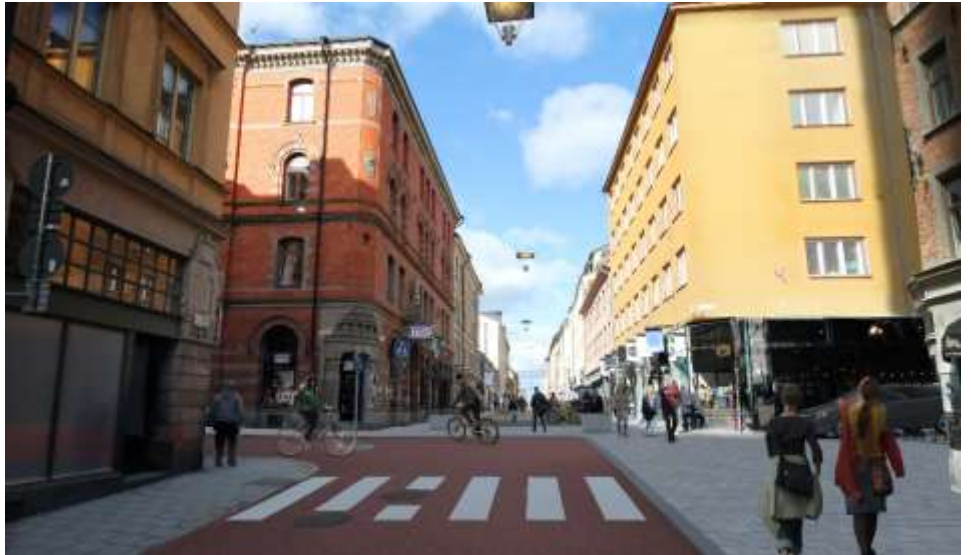
Bild 9. Fotomontage Götgatan/Högbergsgatan. Genomgående gångbanor över Götgatan och Högbergsgatan. Gångbanan till höger i bild breddas inför korsningen.
