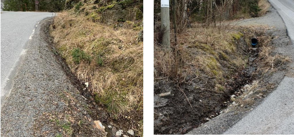
Figur 14. Ytterligare exempel på vägdikey t.v. och trumma under utfart från fastighet t.h..
