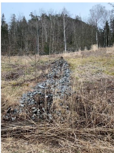
Figur 35. Utlopp 5 med erosionsskydd rekommenderas att bevaras.
