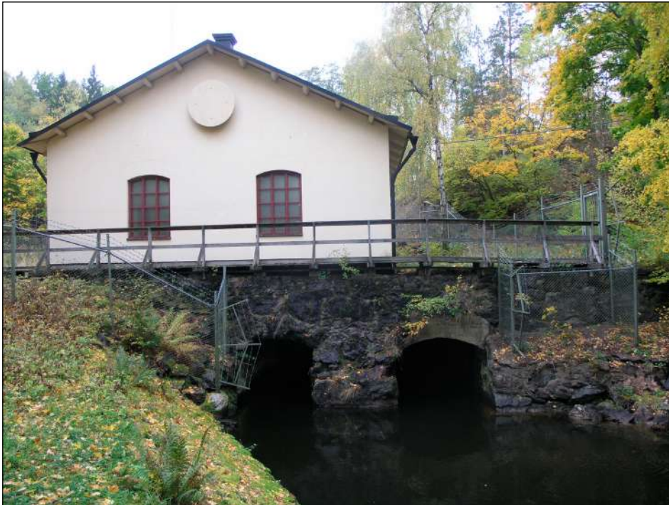
Uddby vattenkraftverk med stensatta strömfäror.
