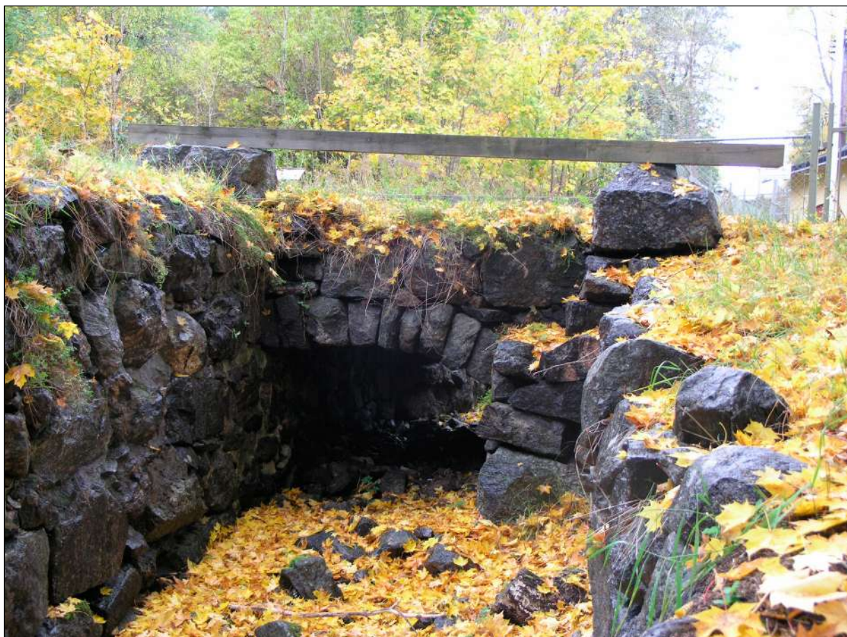
Stensatt strömfåra med vahnslagen bro vid Uddbykvarn.
