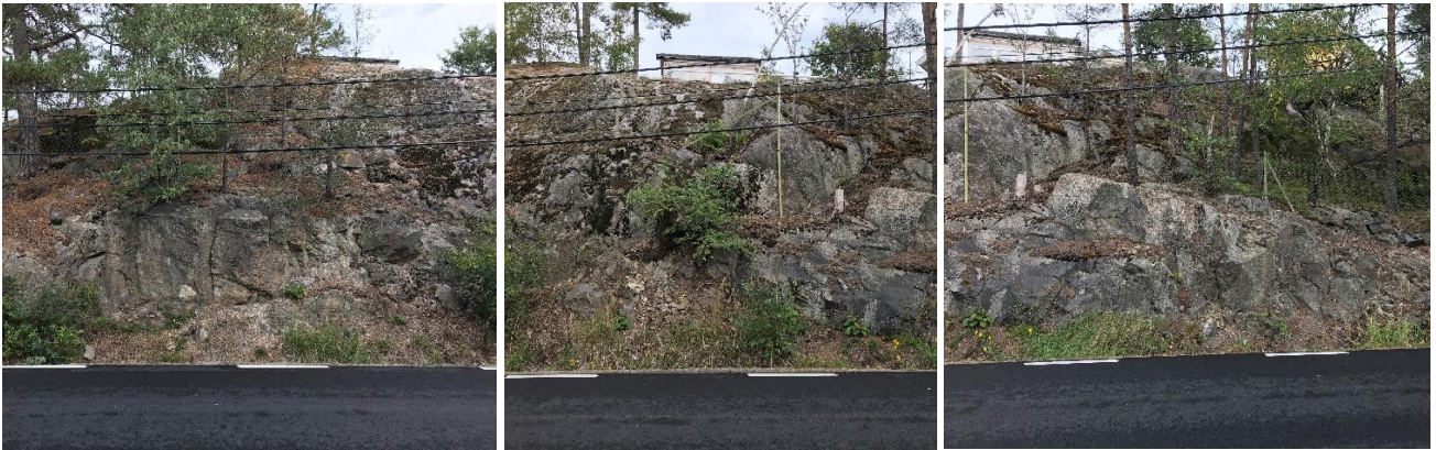
Figur 5: Bergslänt norr om Breviksvägen i km 0/350
