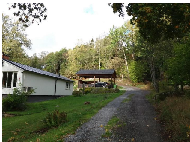
Figur 17: Profil A, bild tagen i km ca 0/040 i riktning nordväst. Berg i dagen skymtar vid höger sida av vägen.
