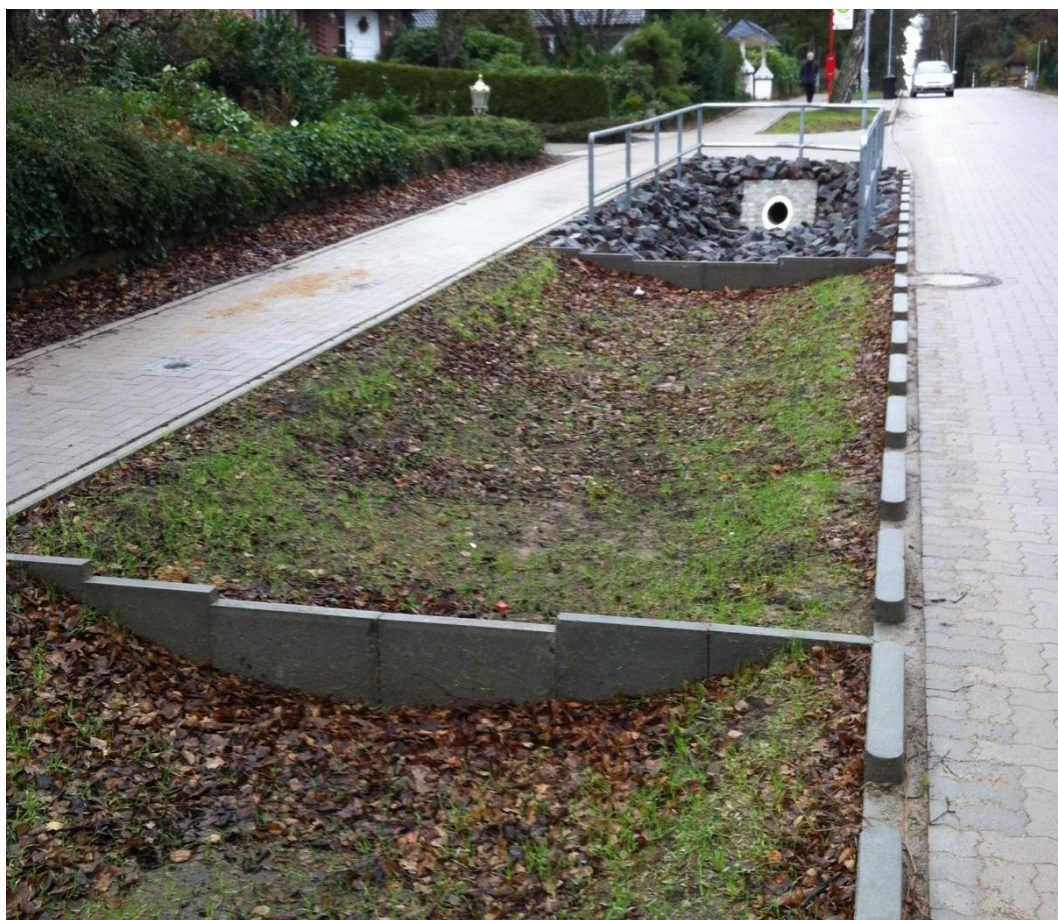
Figur 13. Svackdike med inbyggda dämmen som bildar sektioner i diket. Foto: WRS.
