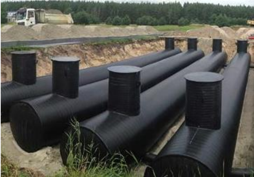
Figur 20. Ett rörmagasin i betong. Magasinet utgörs av parallella ledningar. Bild hämtat från Uponor.
