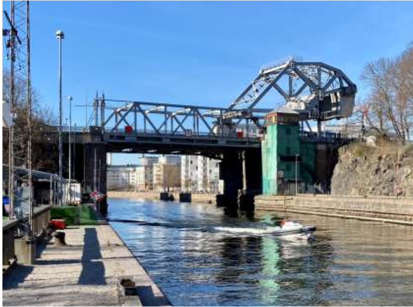
Bild 2. Norra Danviksbron, från sidan norrifrån, före påbörjad renovering.
