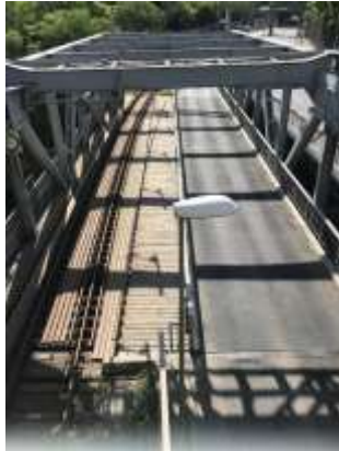
Bild 1. Farbanan på befintlig bro, Saltsjöbanans spår och ett busskörfält.
