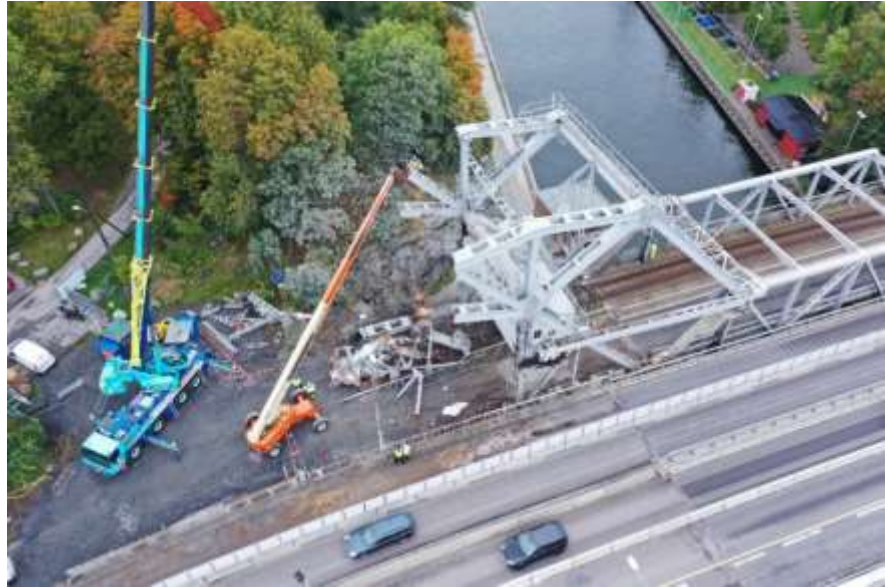
Bild 3. Pågående rivningsarbeten på Norra Danviksbron.
