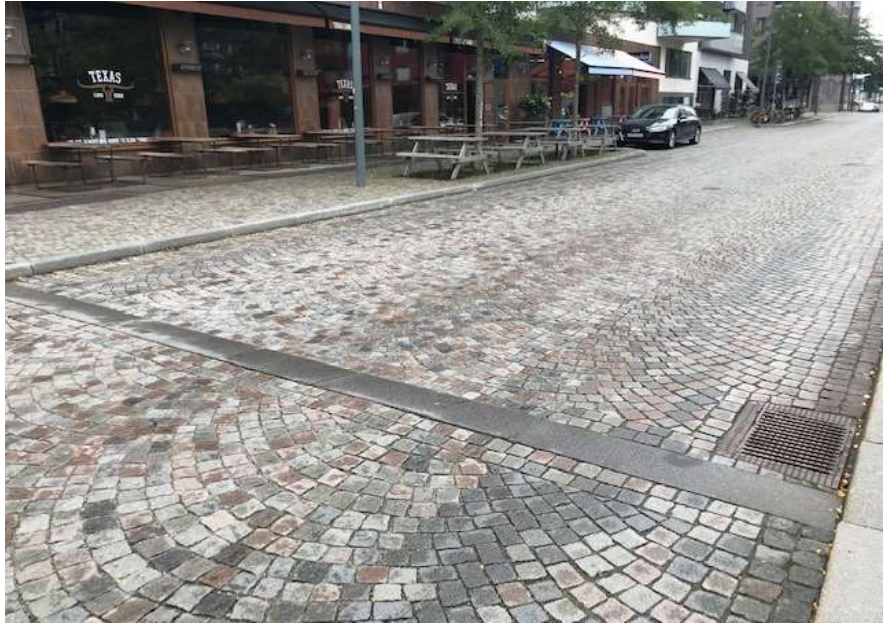
Figur 3. Genomgående kantsten på Lövängsgatan
