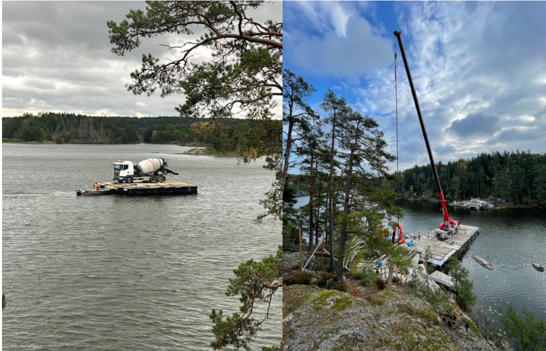
Bild 3 och 4. Transport och montering av dragstänger
