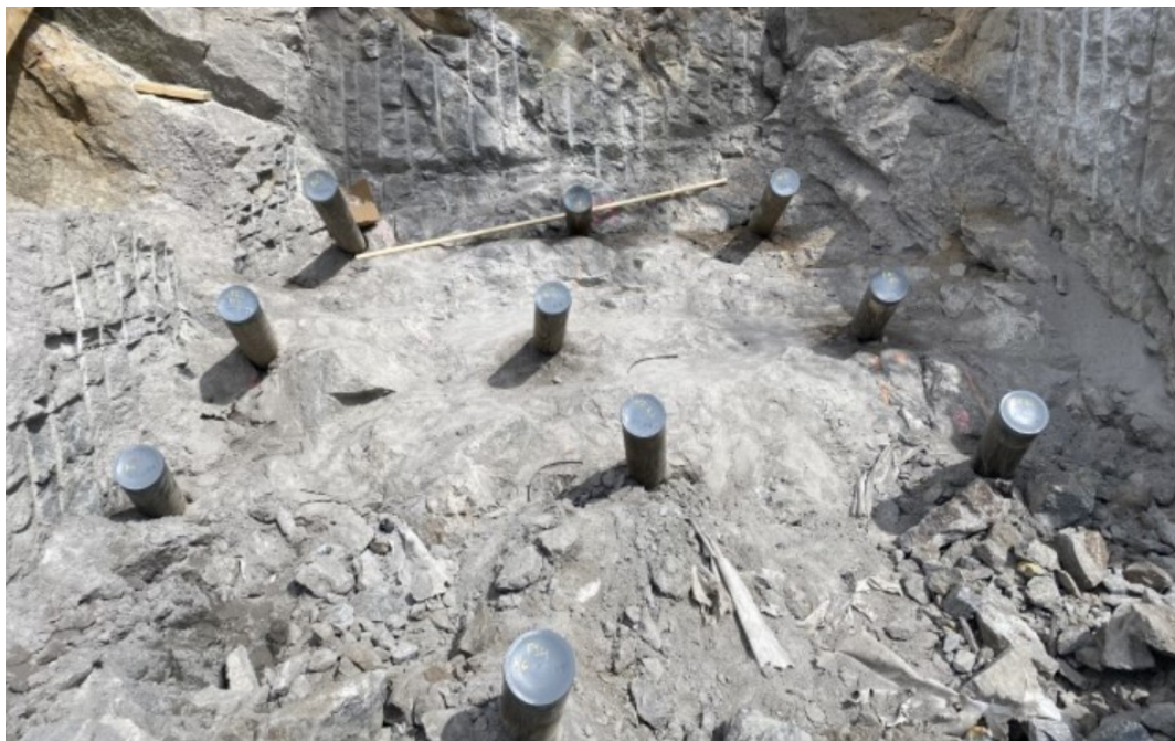
Bild 6. Förberedelse för dragstag, borrhål ca 25 m djupa
