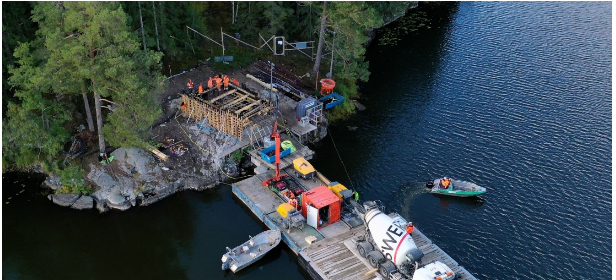
Bild 1. Gjutning av brofäste på Tyrestasidan.
