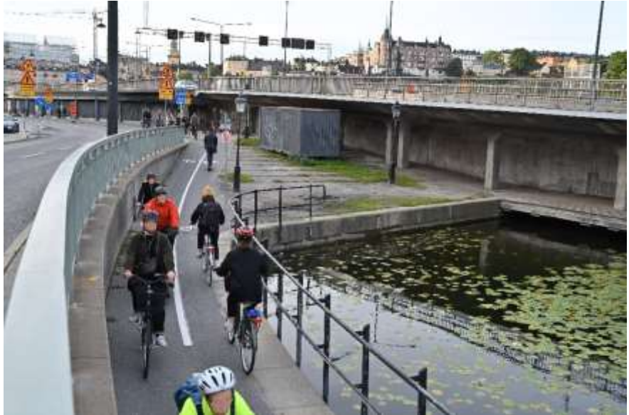
Bild 6. Befintlig cykelbana i riktning mot Gamla stans tunnelbanestation.
