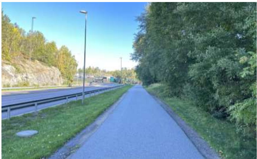
Figur 6, delsträcka 4, sett söderifrån.
