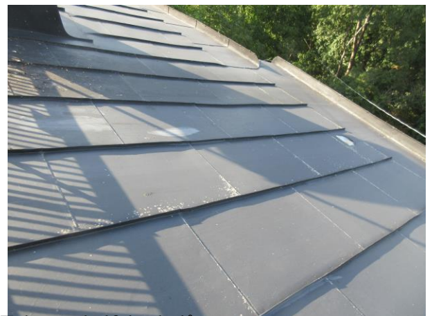
Taket, enkelfalsad plåt
