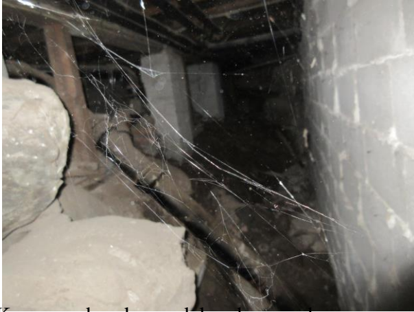
Krypgrund under en del av byggnaden
