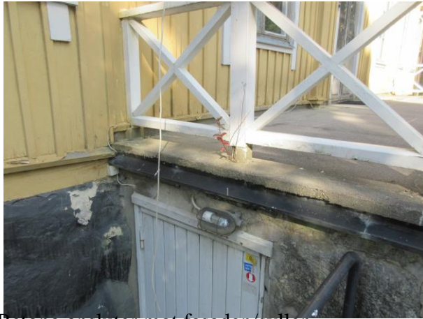
Betong ansluter mot fasaden/syllen
