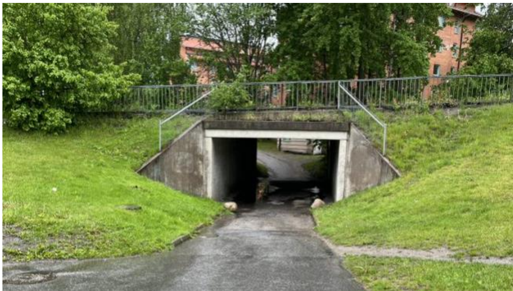
Figur 12 Tunnel under Granängsringen in till skolområdet uppledes som mörk under platsbesöket. (Foto: AFRY).
