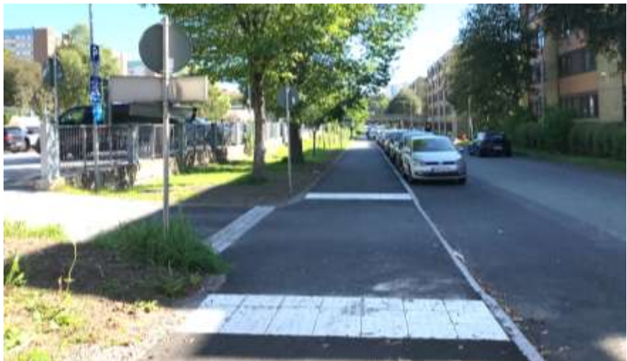
Figur 4. Fotografi som visar åtgärd på Helsingforsgatan efter byggnation, ny gångbana och genomgående gångbana.
