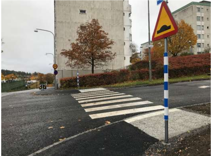
Figur 10. Fotografi som visar åtgärd vid Elinborgsskolan efter byggnation, nytt övergångsställe.
