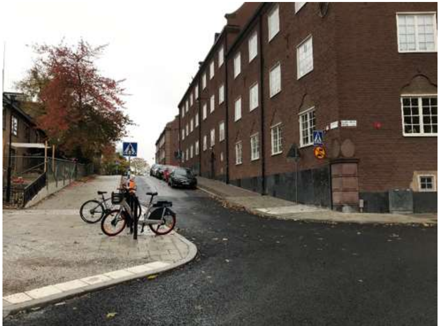
Figur 5. Fotografi som visar åtgärd vid Rödabergsskolan efter byggnation, breddad gångbana och nya cykelställ.
