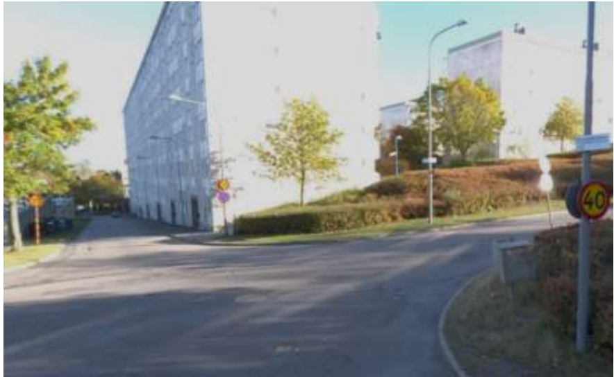
Figur 9. Fotografi som visar korsningen Vissingebacken/Mellingebacken vid Elinborgsskolan före byggnationen.
