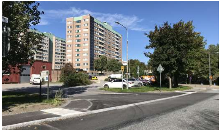
Figur 6. Fotografi som visar åtgärd vid Oxhagsskolan efter byggnation, ny genomgående gångbana.
