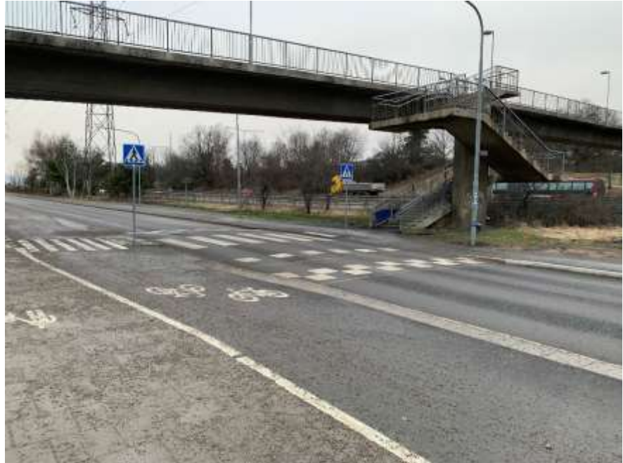
Bild 4. Fotografi som visar det ombyggda upphöjda övergångsstället i anslutning till gångbron över Tyresövägen.
