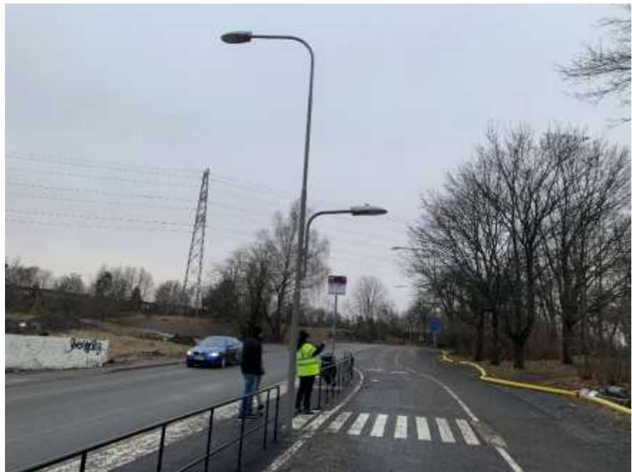
Bild 2 Fotografi som visar den ombyggda hållplatsen Kokoskakan med räcke som separation mellan gång & cykeltrafiken.
