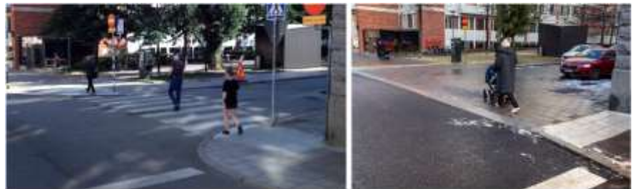
Figur 4. Fotografier som visar korsningen Wollmar Yxkullsgatan och Rosenlundsgatan. Fotografiet till vänster visar övergångsstället innan ombyggnation. Fotografiet till höger visar den genomgående gångbanan efter ombyggnation. Foto: Trafikkontoret
