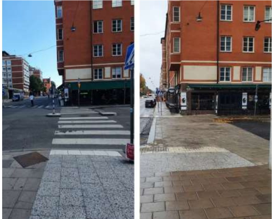
Figur 3. Fotografier som visar korsningen Krukmakargatan och Rosenlundsgatan. Fotografiet till vänster visar övergångsstället innan ombyggnation. Fotografiet till höger visar den genomgående gångbanan efter ombyggnation. Foto: Trafikkontoret.
