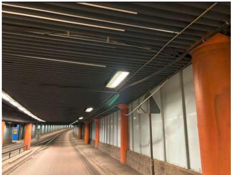
Bild 1. Fotograf som visar tunneltaket med aluminiumprofiler som monterats för att förstärka taket..
