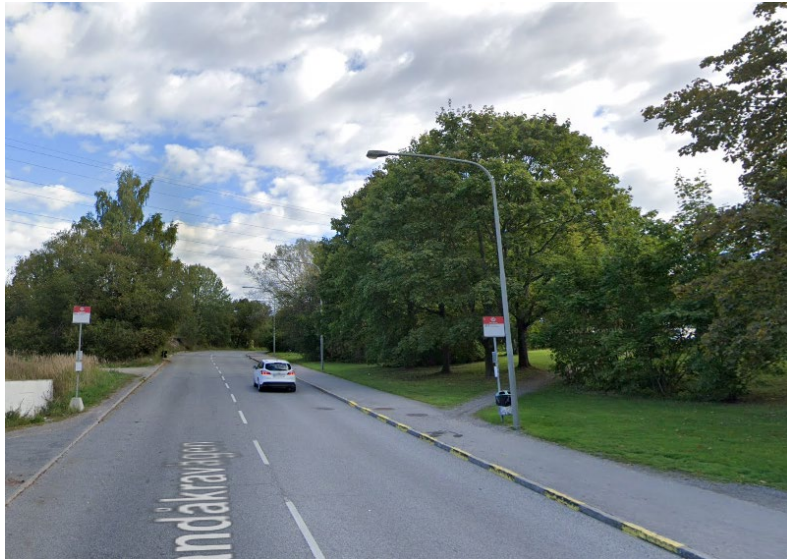
Busshållplats Kokoskakan innan ombyggnad
