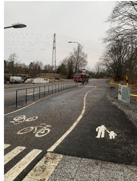
Busshållplatsen efter ombyggnad med räcke mot cykelbana och generösa mått
