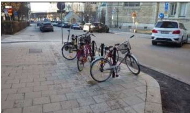
Figur 2. Ny kantstenslinje och utbyggd yta på Fredrikshovsgatan
