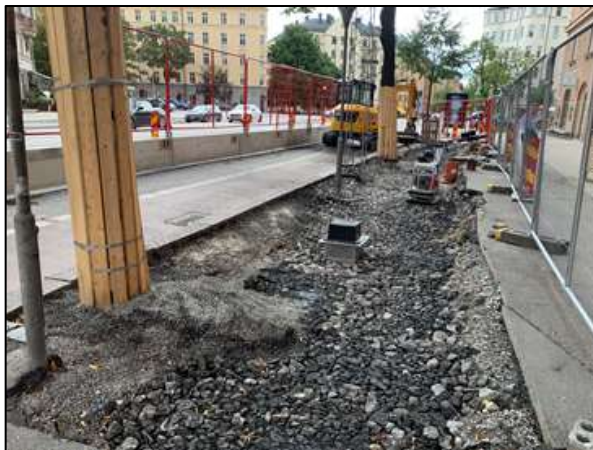
Figur 15, nya växtbäddar med kolmakadam och inlopp för dagvatten anlagt under cykelbana på Sankt Eriksgatan mellan Vanadisplan – Karlbergsvägen (utanför studerad sträcka).
