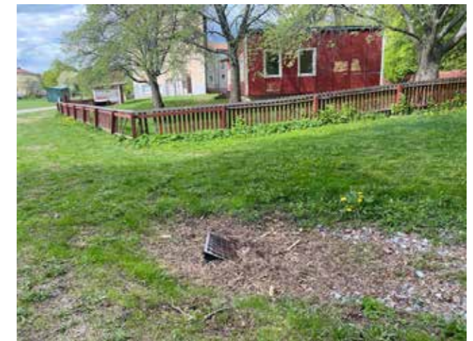
Dike, stenlista och brunn vid Bushuset. Vid större regn rinner vattnet vidare till parken.
