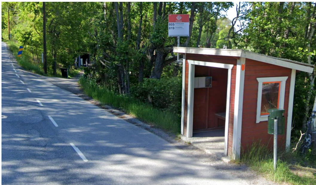
Bild 12 Trinntorp hållplats läge A. En infart norr om hållplatsen gör att hållplatsläget inte kan flyttas norrut. (Bild: Google Maps, bildinsamling: juni 2022).
