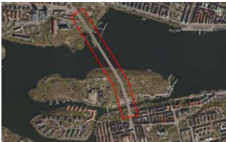
Bild 1: Ortofoto som visar Västerbrons läge. Bron sträcker sig från Kungsholmen över Långholmen till Södermalm.
