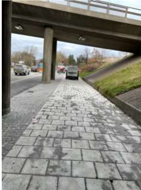
Bild 2 Fotografi som visar Gamla Tyresövägens ombyggda gångbanedel med smågatsten och bropelarna som avgränsning mot cykelbanan.
