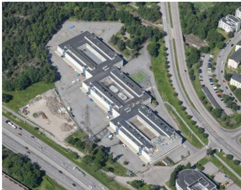
Figur 2: Flygvy från öster med Skärholmsvägen i övre delen och E4/E20 i nedre kanten. Den obebyggda delen av fastigheten består till största delen av hårdgjorda trafikytor.
