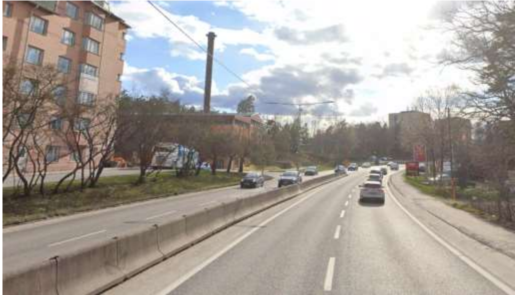
Figur 2. Befintlig situation på Magelungsvägen med mittbarriär mellan körfält.
