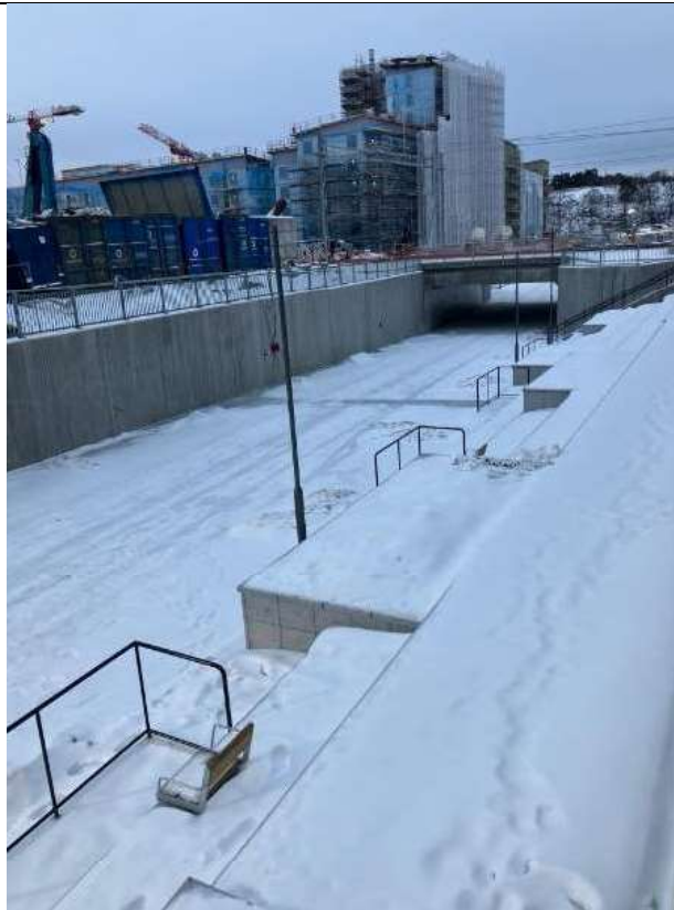
Gradänger vid Bromstenstunneln, sett från söder.
