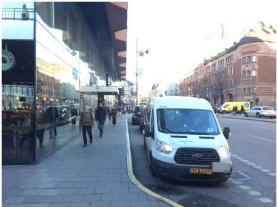
Figur 14. Fotografi taget i november 2017, före ombyggnad. Vasagatan i riktning norrut mot Mäster Samuelsgatan.
