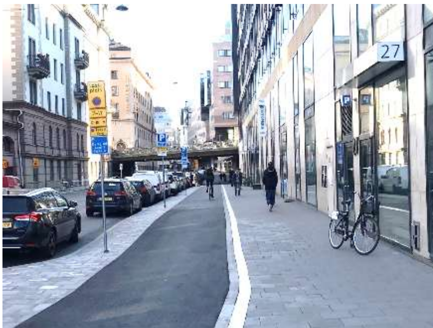
Figur 21. Fotografi taget i september 2019, efter ombyggnad. Östra Järnvägsgatan i riktning mot Vasaplan. Kantstenslinjen har flyttats ut och cykelbanan har breddats.
