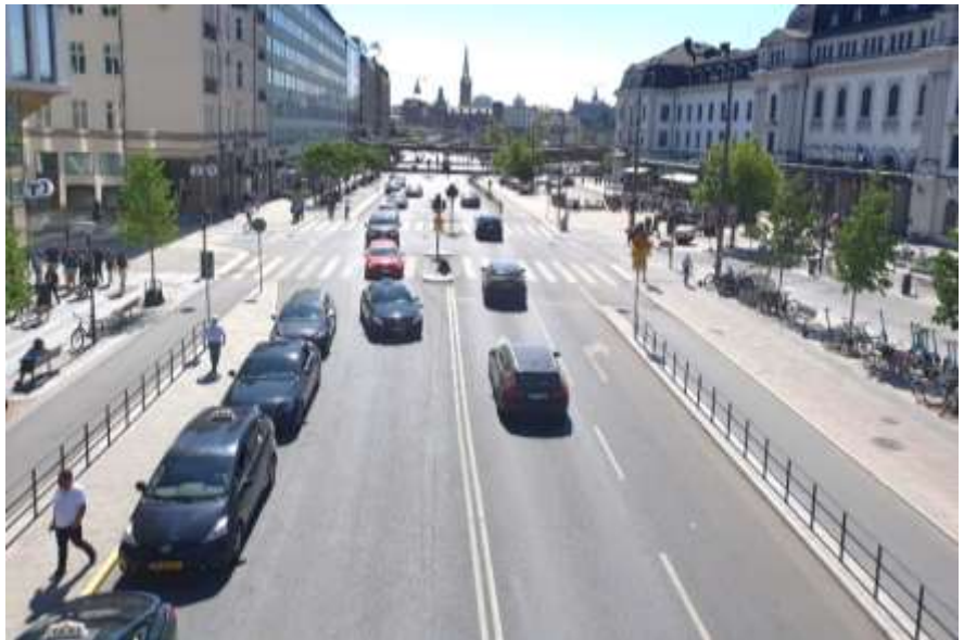
Figur 9. Fotografi taget i juni 2023, efter ombyggnad. Vy från Klarabergsviadukten i riktning söderut. På bilden syns de separerade cykelbanor samt större vistelsezoner med nya gatuträd.
