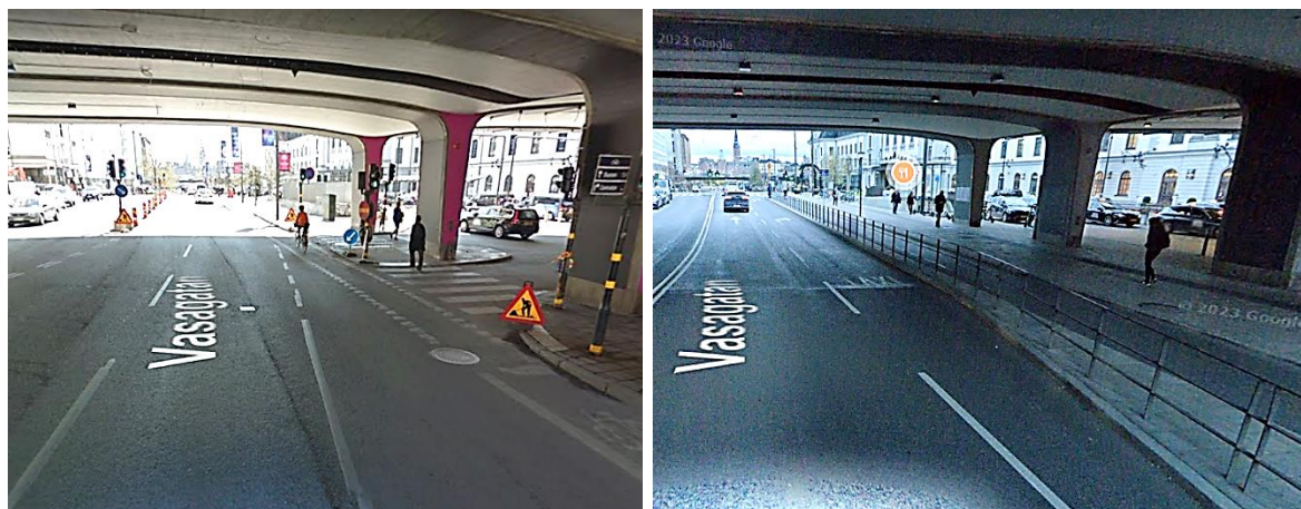
Figur 17. Före- och efterbild från den tidigare taxiinfarten som nu har byggts om. (Källa: Google Maps)
