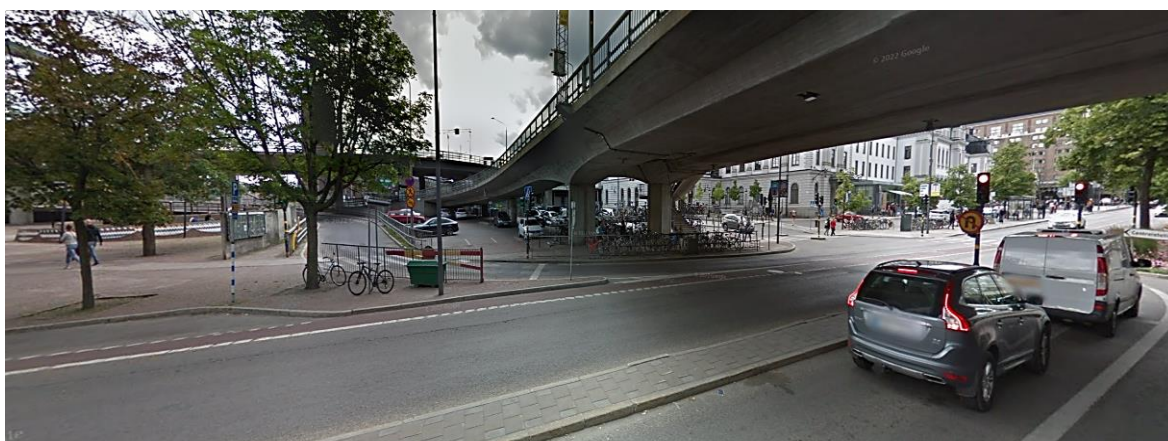
Figur 14. Infarten till Söderkopplet innan ombyggnationen 2019. (Källa: Google Maps)
