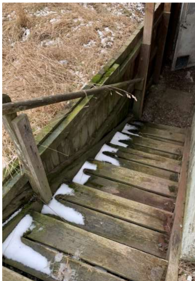
Källartrappa med stödmur av trä.
