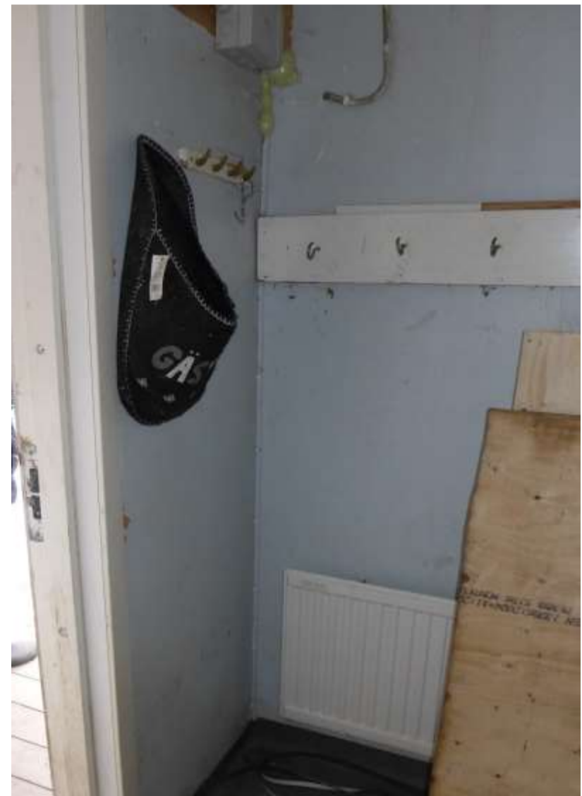
Bottenvåning. Rum 201 Hall. Tätning med fogskum. Olika krokliester.
