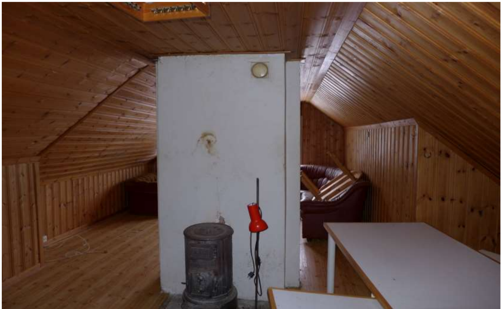
Rum 304. Murstock med putssläpp. Helt inbyggd kattvind utan tillrädslucka.
