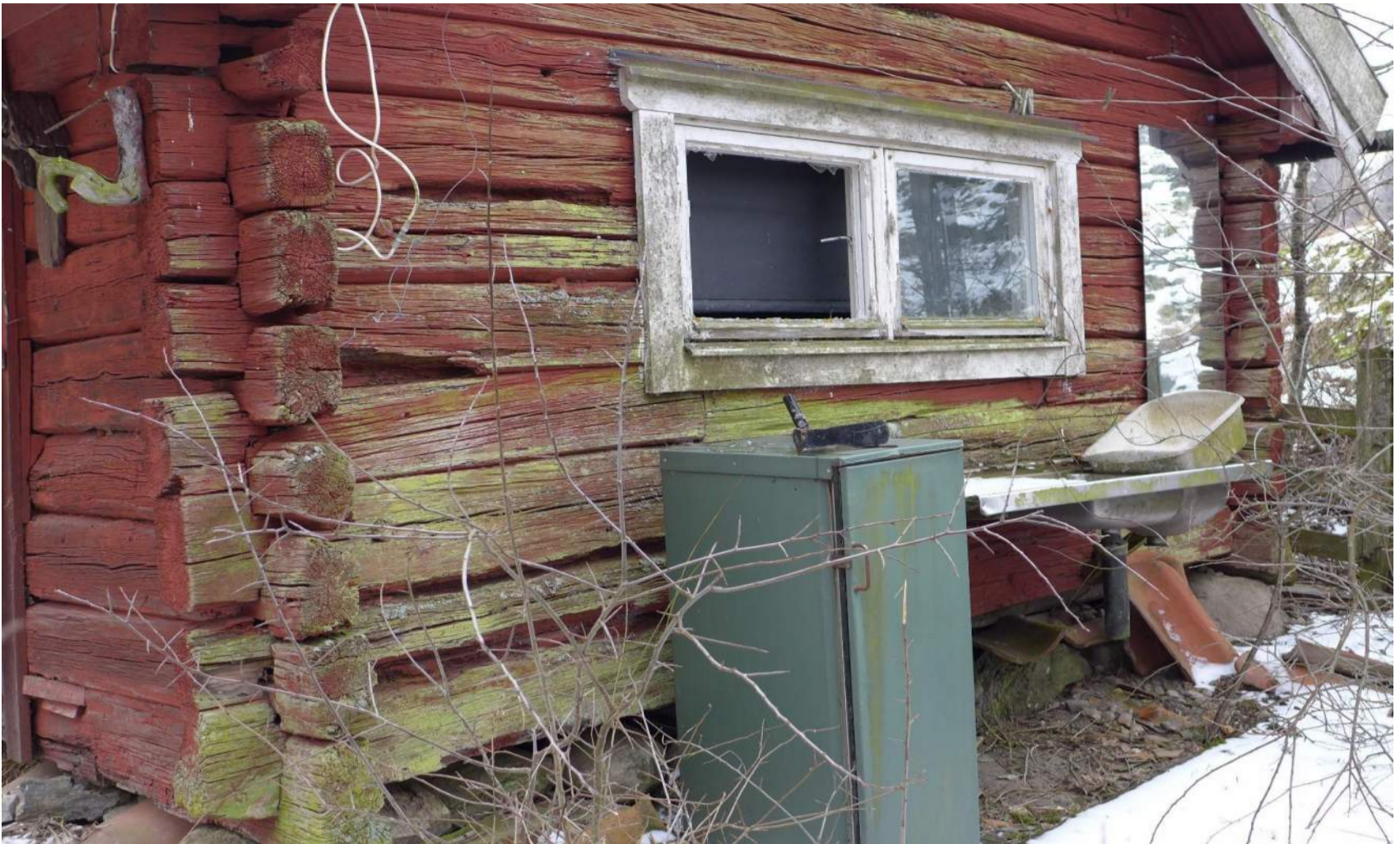
Fasad mot öst och sjön. Vittrade stockar. Fönster med trasigt glas och renoveringsbehov.
