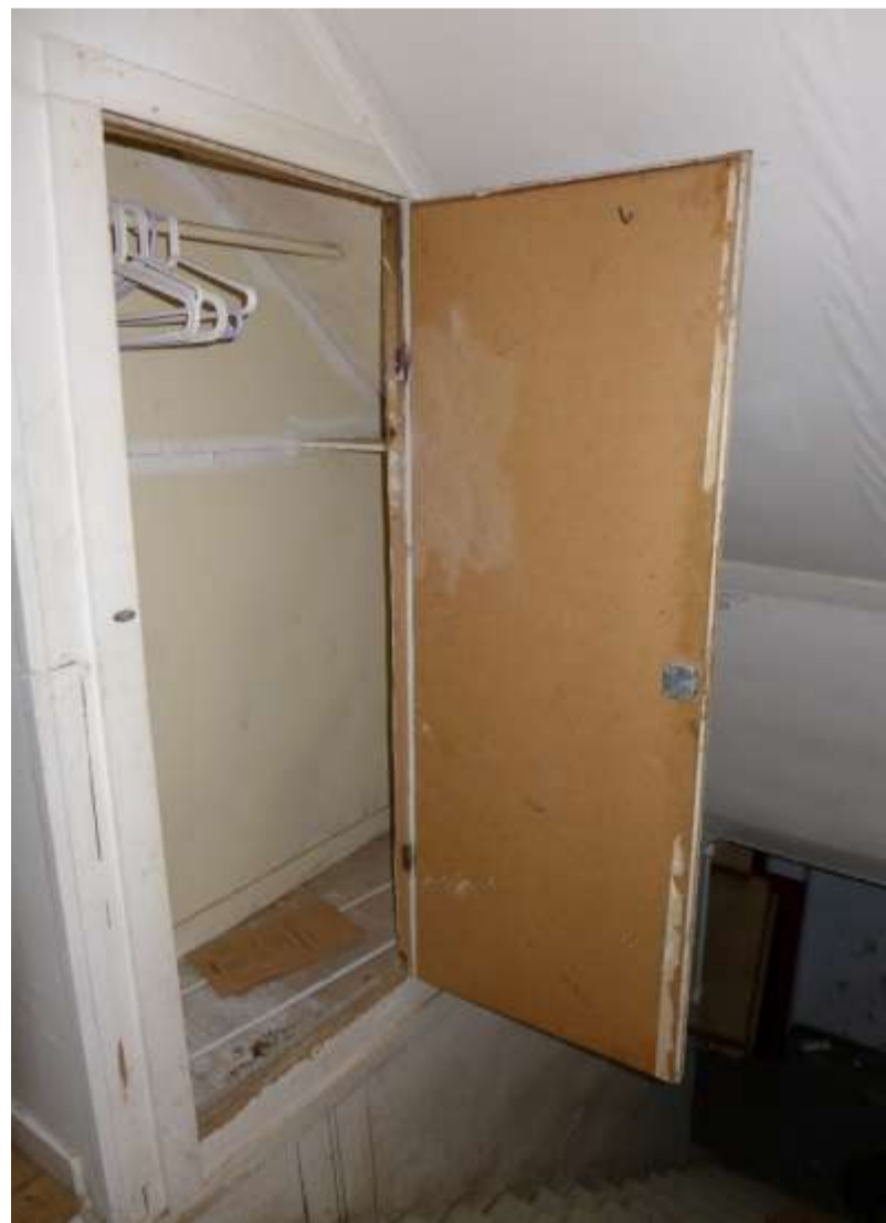
Rum 301 Hall. Garderob mot trappa. Omålad insida dörr.
