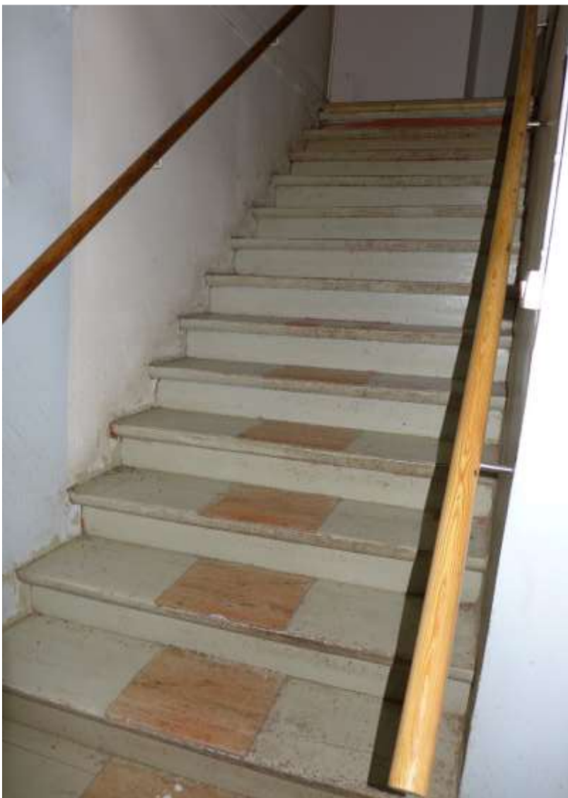
Bottenvåning. Rum 201 Hall och trappa. Målade steg med två lager pålimmad matta. Lite olika handledare.
