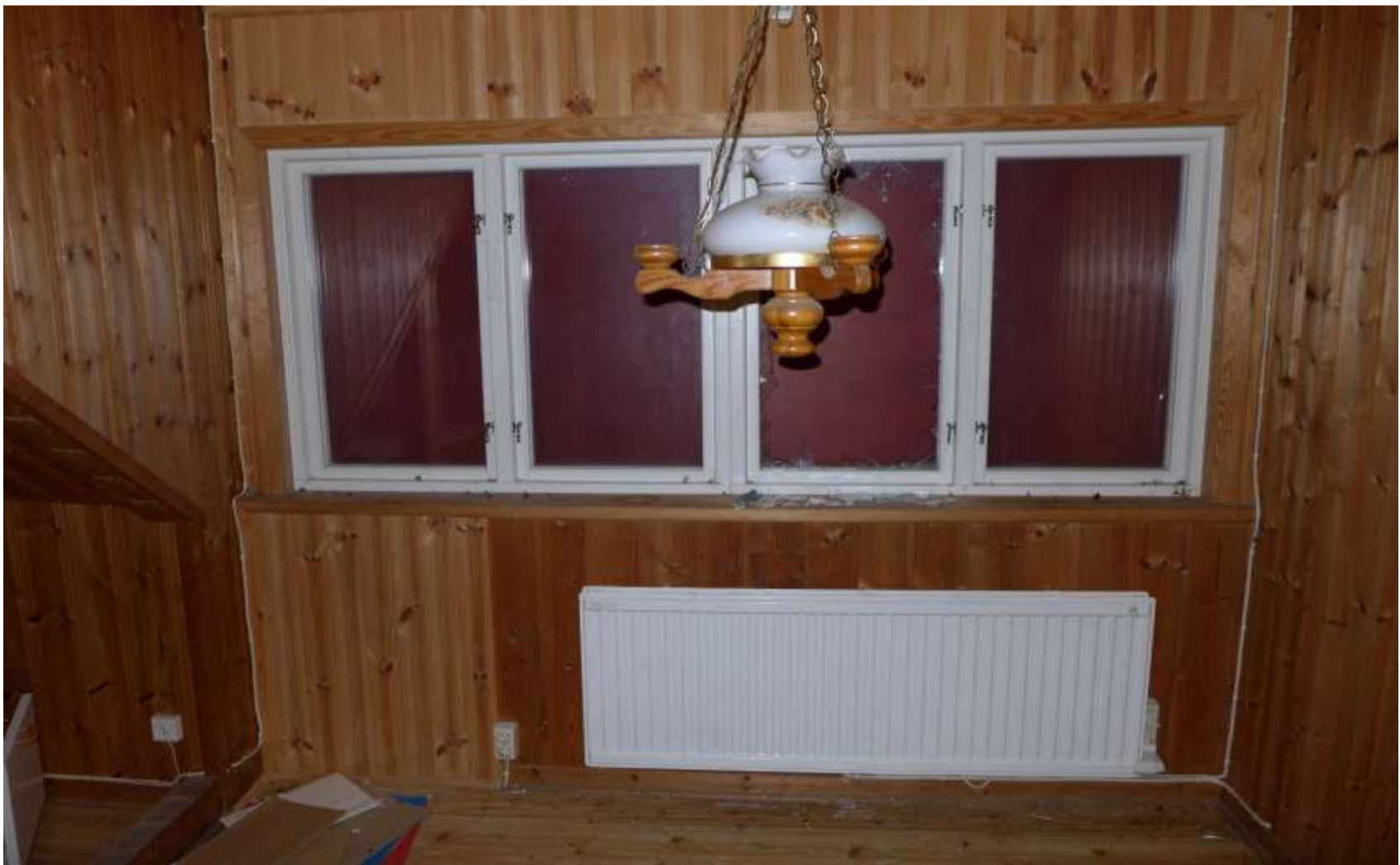
Rum 304. Fönster med trasigt glas men i övrigt gott skick. Panel ilagad efter tidigare fönsterdörr.
