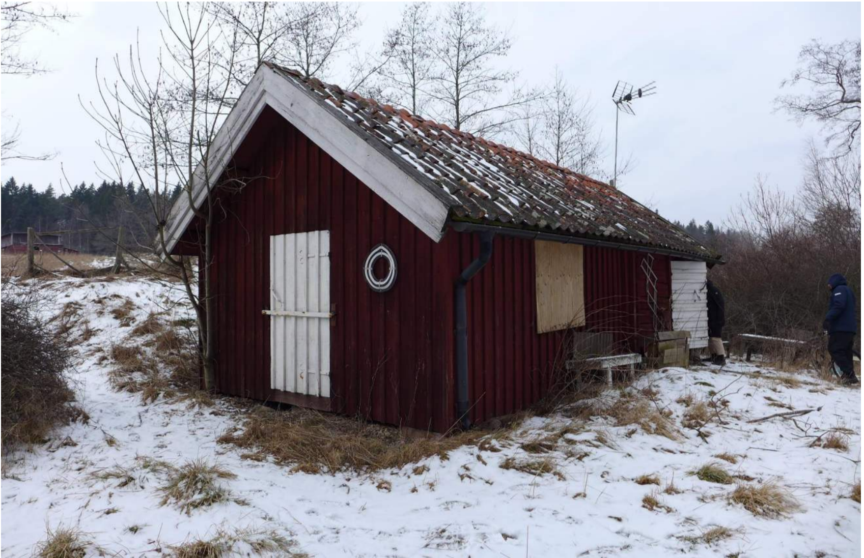
Hörn i sydväst. Färg nött på vindskivor.
