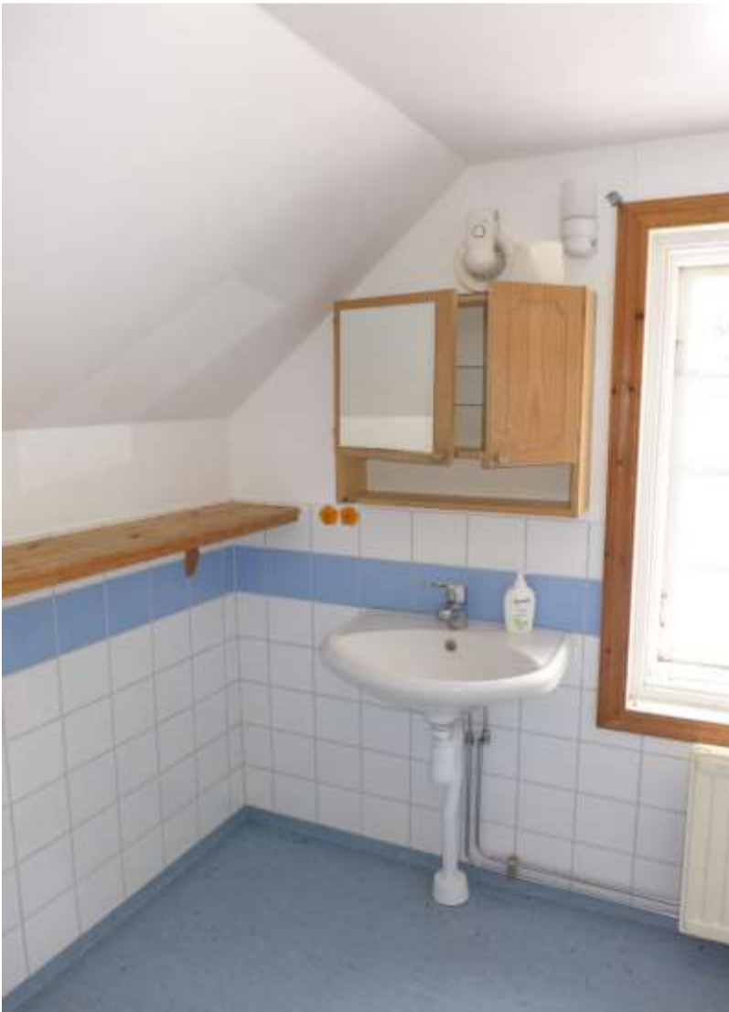
Rum 303 Badrum. Fönsterfoder i furu.
