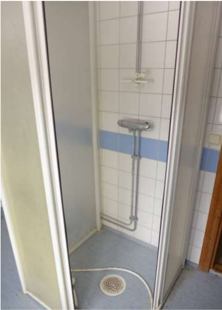
Rum 303 Badrum. Duschkabin
