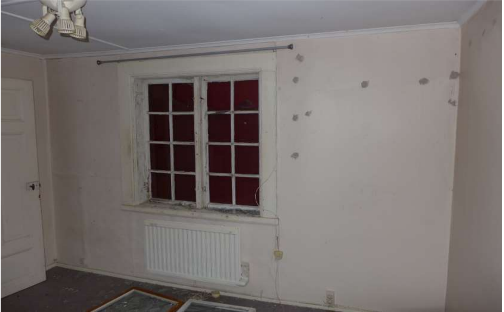
Rum 203, Kammare. Lösa innerbågar med trasigt glas. Väggar av treetex. Spacklingar som ej målats över.
