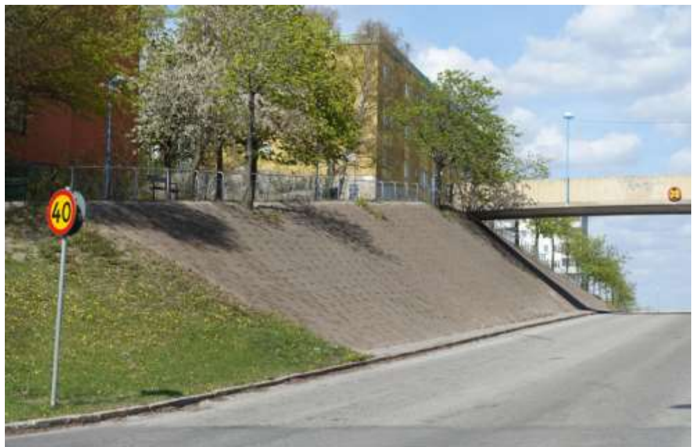
Figur 2. Fotografi förevisande Hagstråkets glacis sett i riktning norrut från korsning Elinsborgsbacken före ombyggnation.
