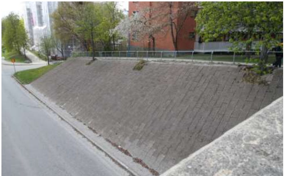
Figur 4. Fotografi som visar Hagstråkets glacis sett från 2:a Hagstråksbron före ombyggnation.
