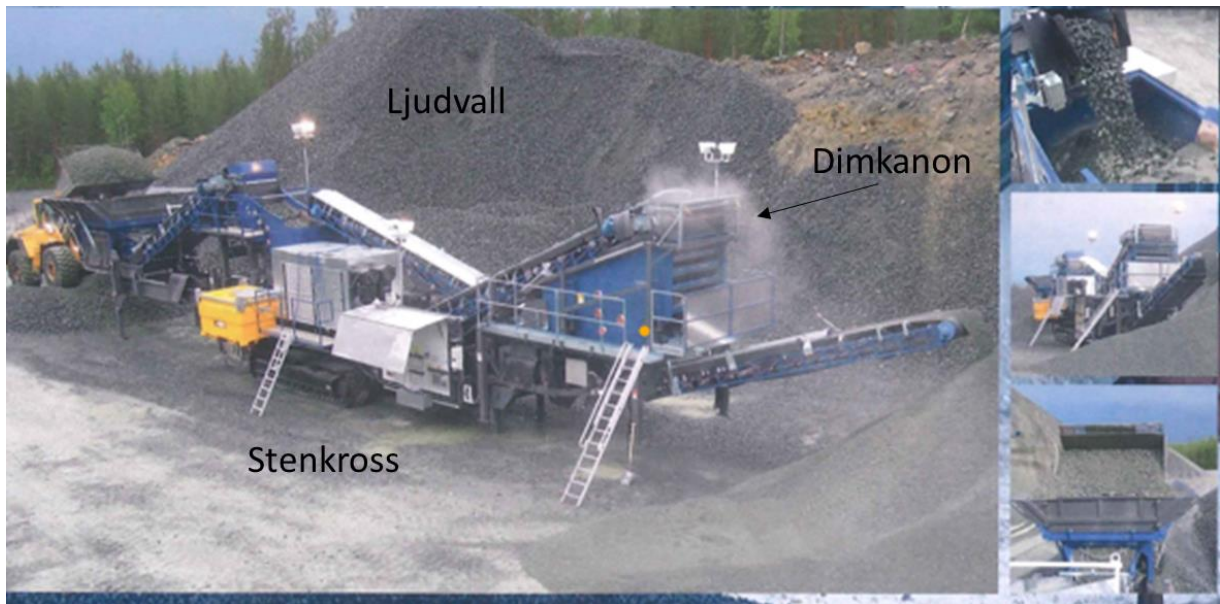
Fig. 8 Exempelbild på en stenkross som kan användas med en ljudvall av massor och en dimkanon
