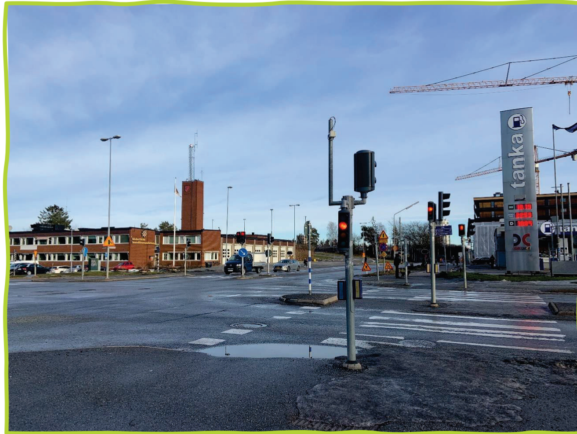
Figur 18. Övergångsställe vid Njukärsvägen med ojämnt markunderlag och dåliga siktlinjer vad gäller gångvägens sträckning framåt. Foto: AFRY
