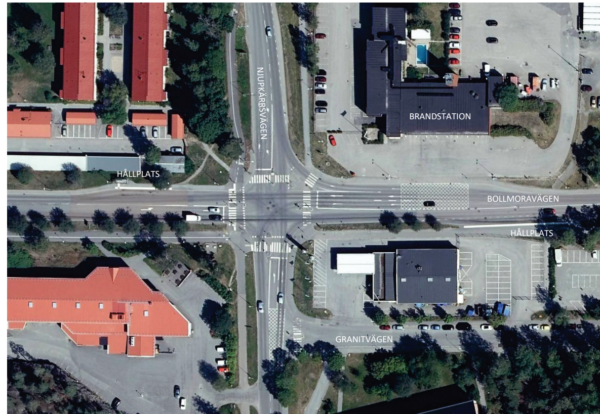
Översiktsfoto över korsningen Bollmoravägen-Njukärsvägen som visar befintlig utformning.
