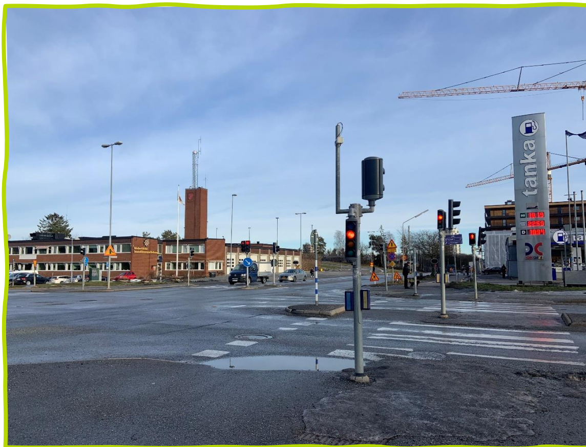
Figur 18. Övergångsställe vid Njukärsvägen med ojämnt markunderlag och dåliga siktlinjer vad gäller gångvägens sträckning framåt. Foto: AFRY
