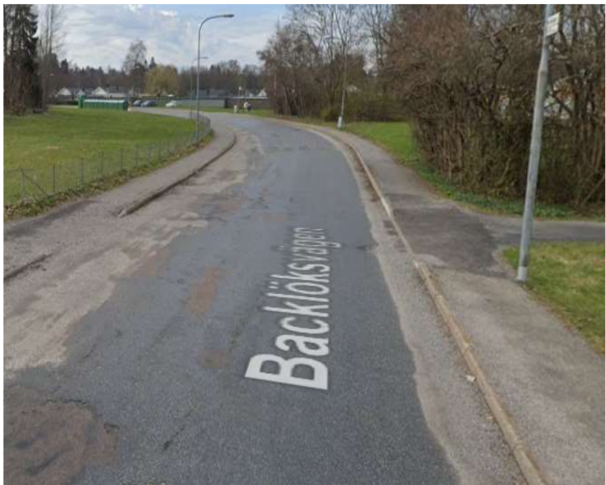
Figur 6: Fotografi förevisande Backlöksvägen 83 efter ombyggnaden nu med sänkt kantsten med syfte att skapa bättre tillgänglighet för gående och cyklister.
