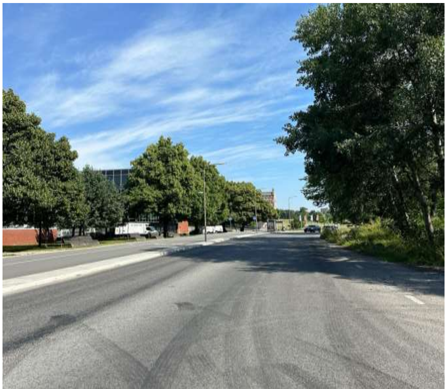
Figur 4: Fotografi förevisande gång och cykelvägen vid Lindarängsvägen efter ombyggnaden. Gång och cykelvägen är bredare och har en skiljeremsa mot körfältet för motorfordon.
