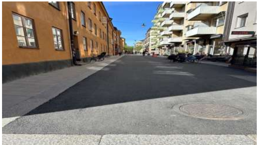
Figur 6: Fotografi förevisande Södermannagatan efter ombyggnad, gata och gångbana är nu i samma nivå.
