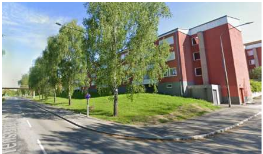
Figur 2: Fotografi förevisande den nyanlagda gångbanan på Tenstagatan 80 - 88.
