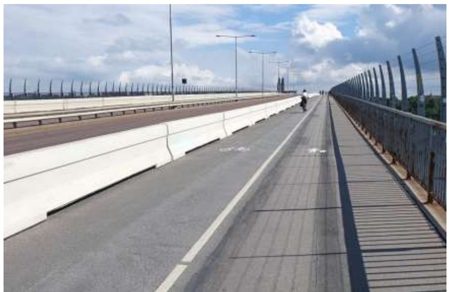
Figur 5: Fotografi som visar Västerbrons västra gång- och cykelbana efter ombyggnation.
