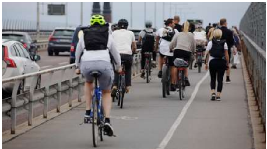
Figur 4: Fotografi som visar Västerbrons västra gång- och cykelbana, före ombyggnation.
