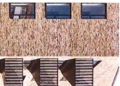
Gavel i tegel med bibehållen fönsterprincip.
