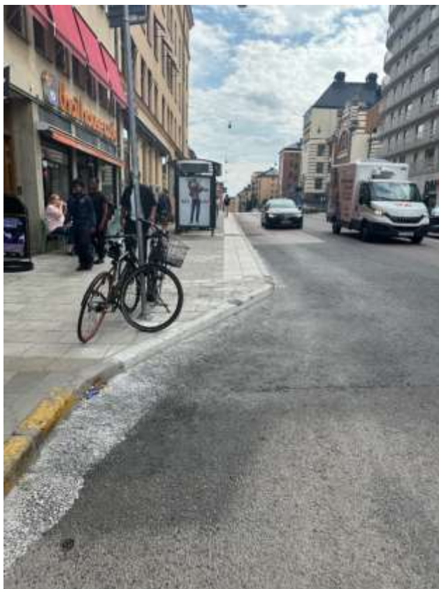
Figur 11. Förlängning av klackhållplats på Hantverkargatan vid hållplats Kronobergsgatan
