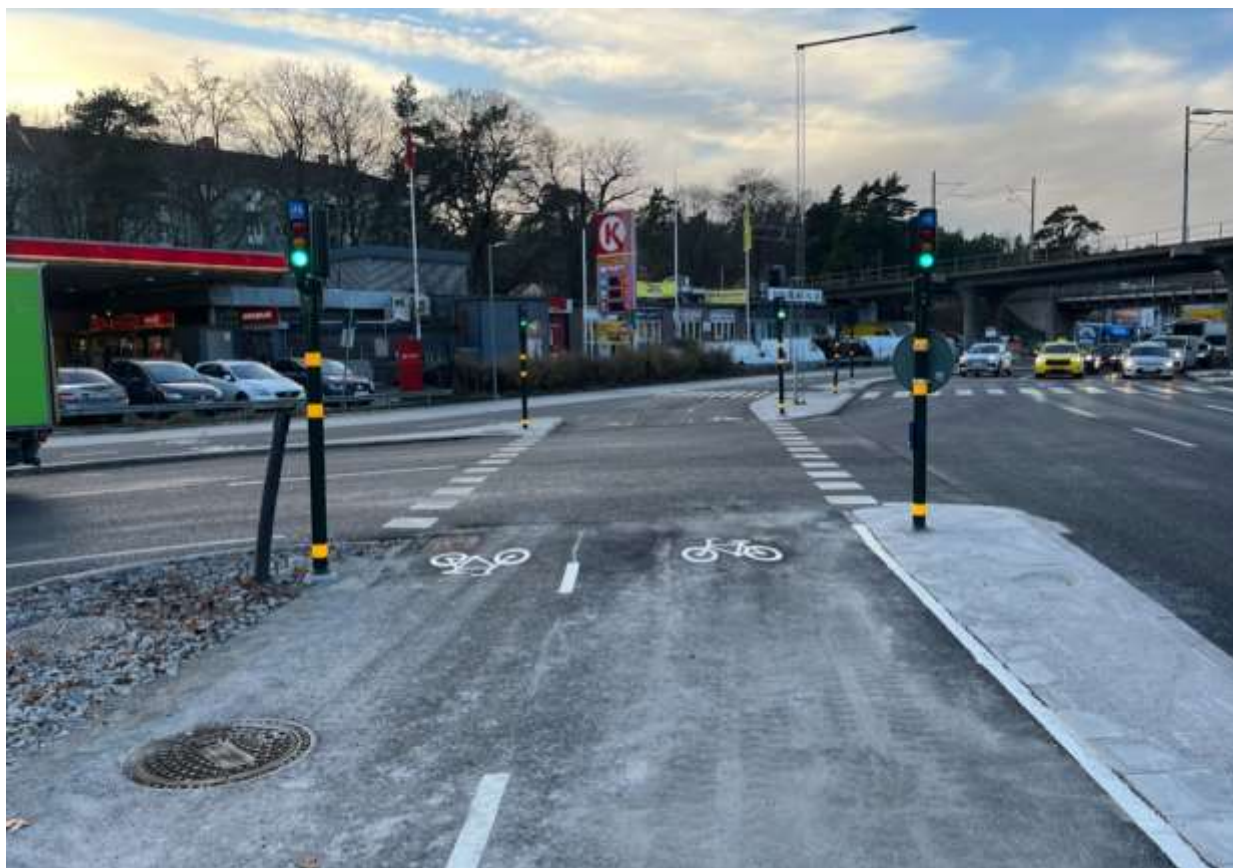
Figur 12, nya och breddade gång och cykelbanor på Drottningholmsvägen förbi Alvik
