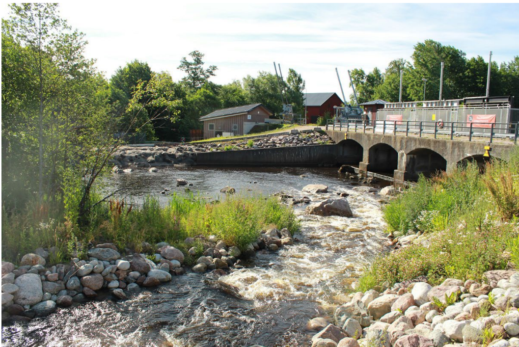
År 2020 beslutade regeringen om den nationella planen för moderna miljövillkor för vattenkraften (NAP). Alla anläggningar som har anmält sig till nationella planen (NAP) ska omprövas för att få moderna miljövillkor. Bild: Vattenkraft med faunapassage i Östuna-Hedströmmen. Foto: LIFE IP Rich Waters
