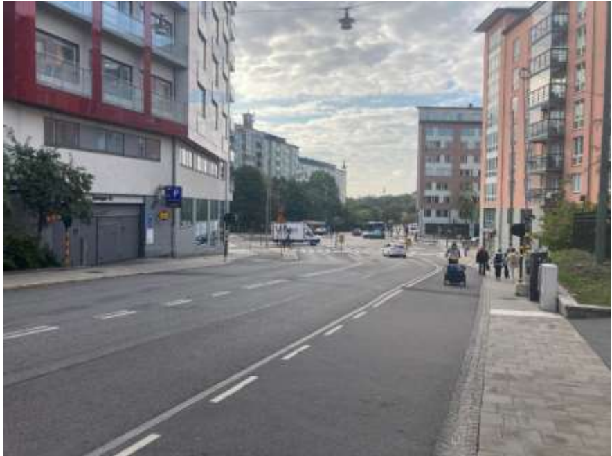
Bild 10. Fotografi som visar den nya cykelbanan på Mariebergsgatan ner mot korsningen med Drottningholmsvägen, cykelbanan är upphöjd och gång och cykelbanan separeras av en rännal utförd med smågatsten.
