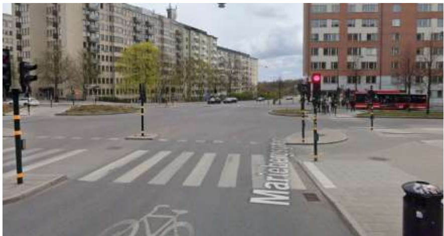
Bild 13. Fotografi som visar hur korsningen Mariebergsgatan/Drottningholmsvägen såg ut före ombyggnaden. Cykling sker i blandtrafik och för befintlig cykeltrafik har linjeföringen brister.
