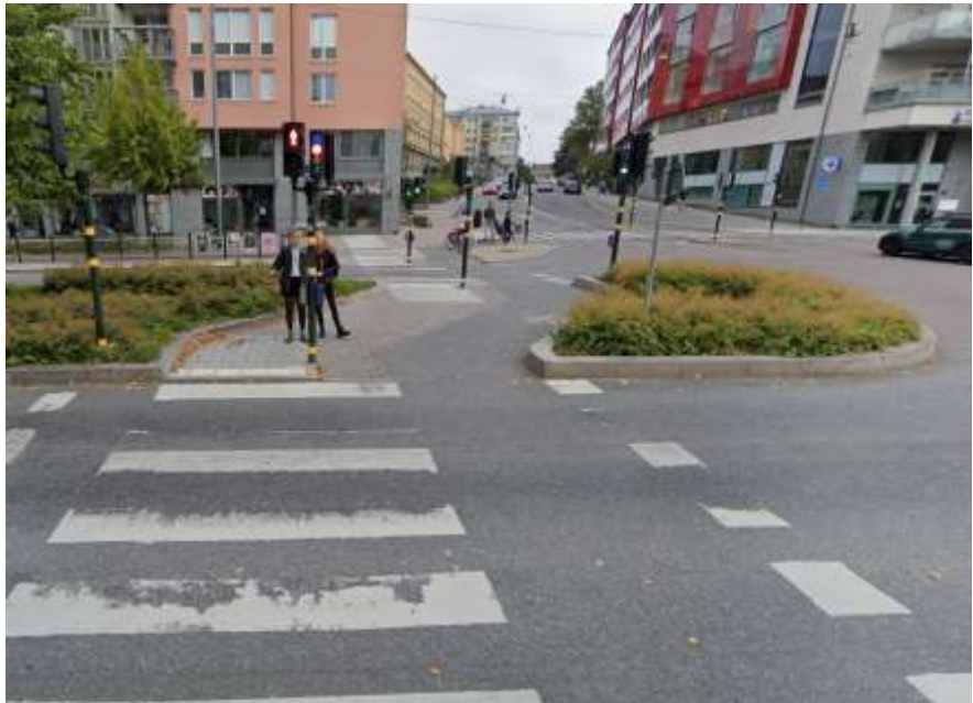
Bild 15. Fotografi som visar hur övergångsstället på Drottningholmsvägen såg ut före ombyggnaden. Linjeföringen på platsen har brister.
