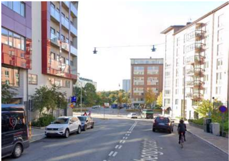
Bild 11. Fotografi som visar hur Mariebergsgatan ner mot korsningen med Drottningholmsvägen såg ut före ombyggnaden.
