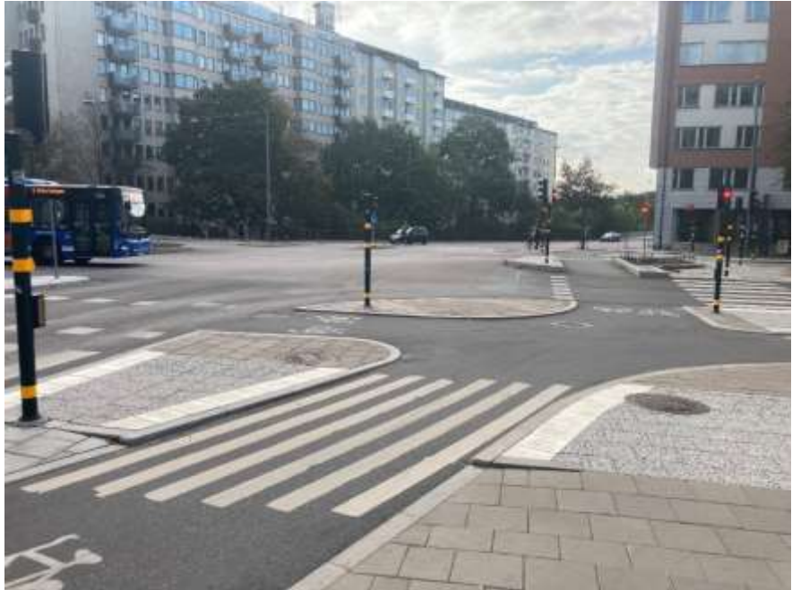
Bild 12. Fotografi som visar de nya cykelbanorna i korsningen Mariebergsgatan/Drottningholmsvägen.
